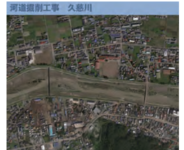
久慈川河道掘削
