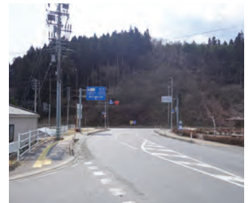
大成橋南信号機設置
