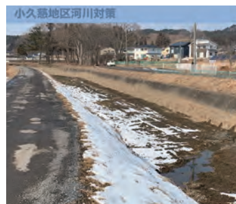
小久慈大沢田川土砂撤去
