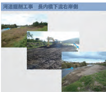
長内川河道掘削
