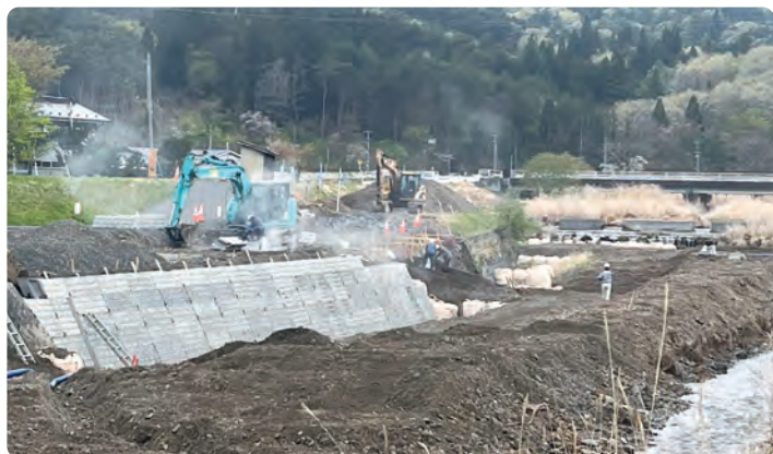
夏井川護岸工事
