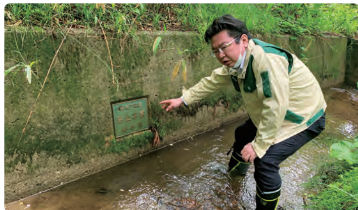
小久慈町日吉地区治山工事
