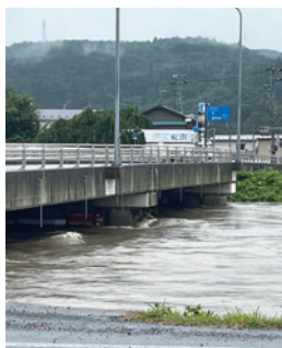
8月12日13:50時点 長内橋通行止めの長内川。
